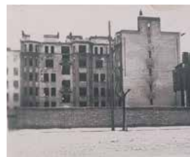
■ Полуразрушенное здание Сетевязальной фабрики, 1946
