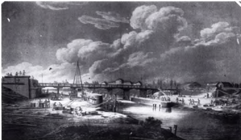
Строительство нового моста через Тигоду
