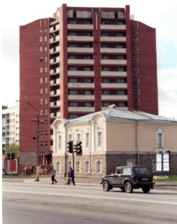
г. Тосно. Жилой дом на пр. Ленина
